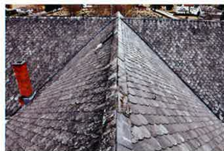
Videre arbeid med tak og vegger i Nes kirke fortsetter i 2014. Det er mye tak å ta tak i!
