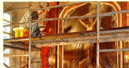
Det ble nødvendig å sette opp et lite stillas for å få utført arbeidene rundt alterbildet.
