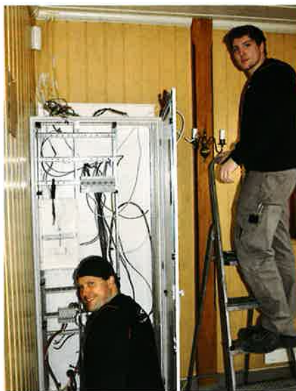
Knut Hoveng og Ola Spildrejorde fra Søbstad Elektroengineering i ferd med å montere ny hovedtavle i gangen inn til Flå kirke.
