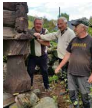
Stolphuset ble jekket opp så stabbene under kunne justeres. Her er hele bunnstokken under inngangen råtten, den blir skiftet senere.
